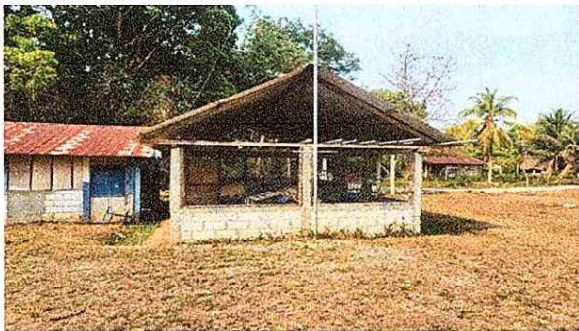
Foto 5: sustitucion de maya por balcones de metal
